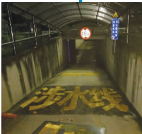
下穿隧道的涉水线
